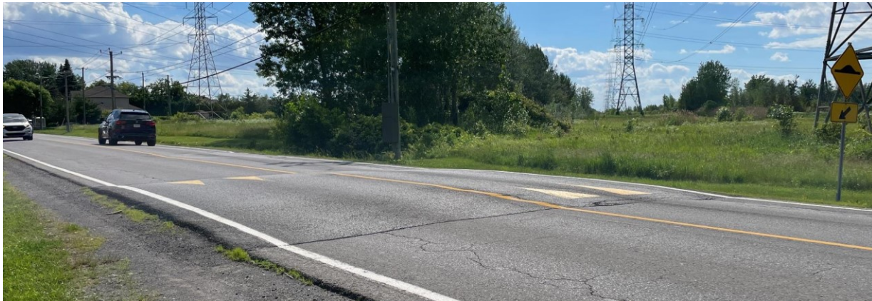
Figure 11 : Dos d'âne allongé sur le chemin Saint-José à La Prairie
