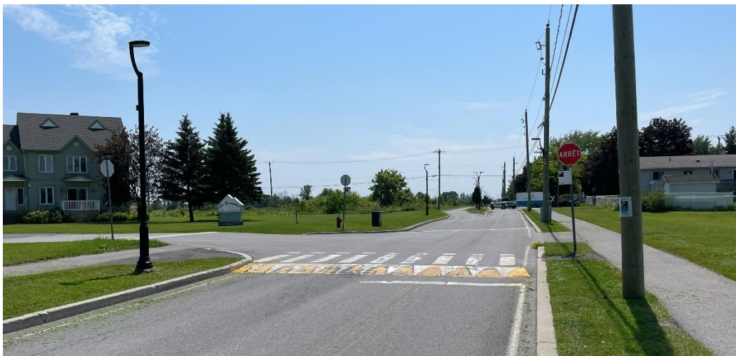
Figure 9 : Intersection surélevée sur le chemin du Canal
