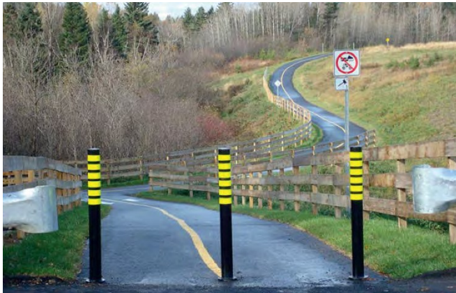
Figure 36 : Balises flexibles munies de bandes réfléchissantes (Kalitec Inc.)
