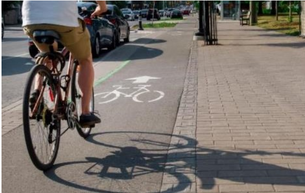
Figure 58 : Surélévation au niveau du trottoir et bande podotactile, rue Main, Ottawa
