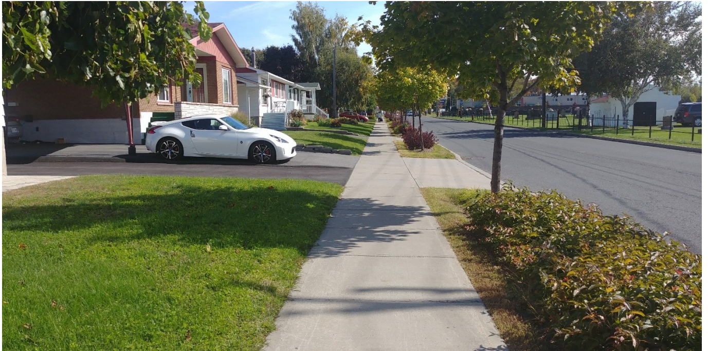
Figure 29 : Trottoir séparé de la chaussée par une banquette, rue Saint-Antoine, Contrecoeur
