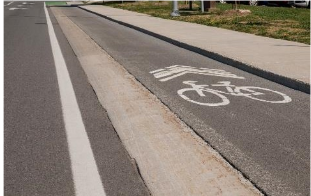
Figure 59 : Surélévation franchissable, boulevard Le Corbusier, Laval
