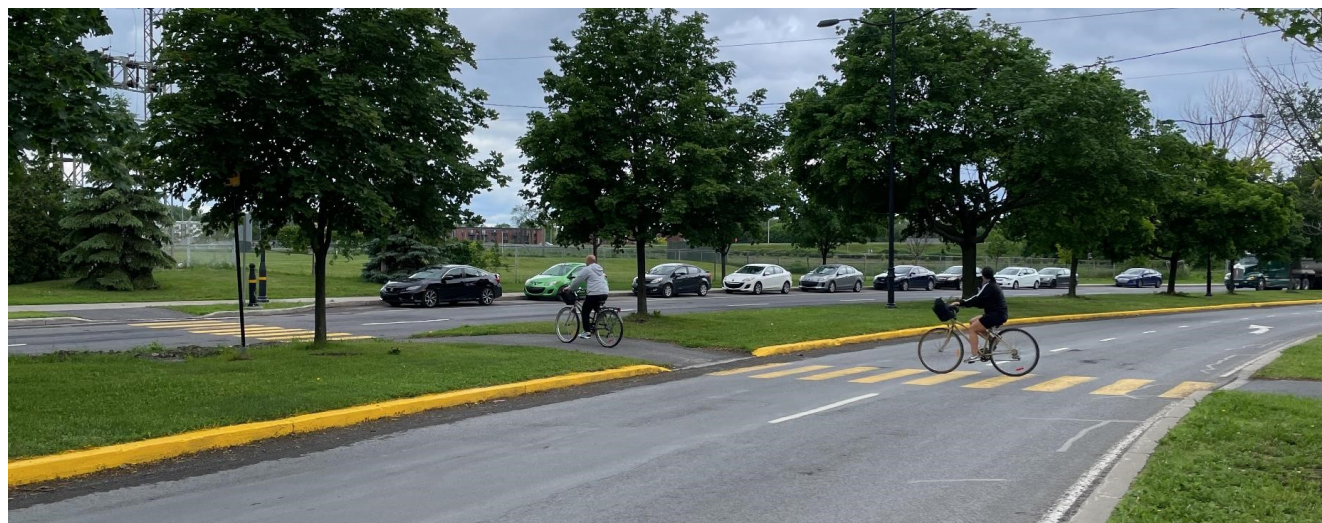
Figure 7 : Îlot refuge - Boulevard Saint-José à La Prairie
