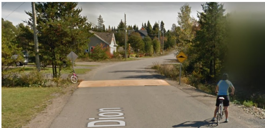
Figure 69 : Chaussée désignée, rue Dion, Val-David (Google)
