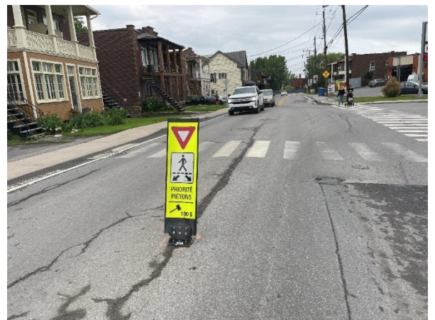
Figure 15 : Balise flexible sur la rue Saint-Laurent
