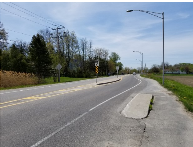
Figure 20 : Îlot déviateur sur la route 138 à Lavaltrie
